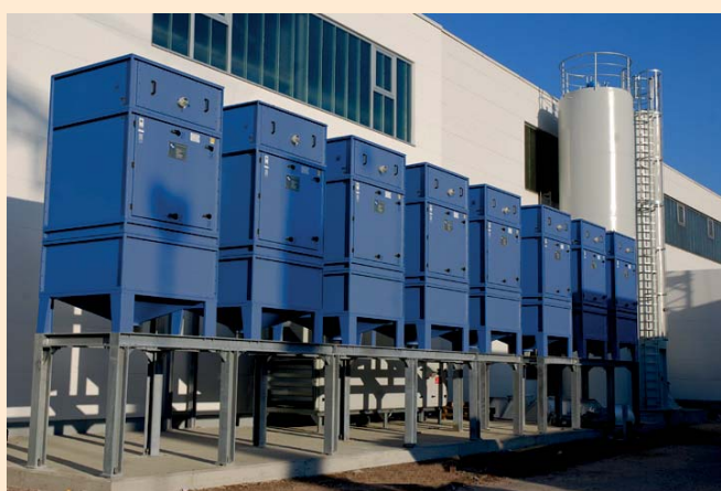
ZPF mit nebenstehendem Ventilator im Schalldämmgehäuse
