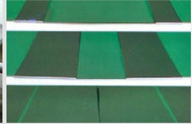
Überlappungsdarstellung **33%** = 50 mm für leichte Zugluft, kurze Längen **66%** = 100 mm für mittlere Zugluft und größere Höhen. **100%** = 150 mm für starke Zugluft und als Lärmschutz
