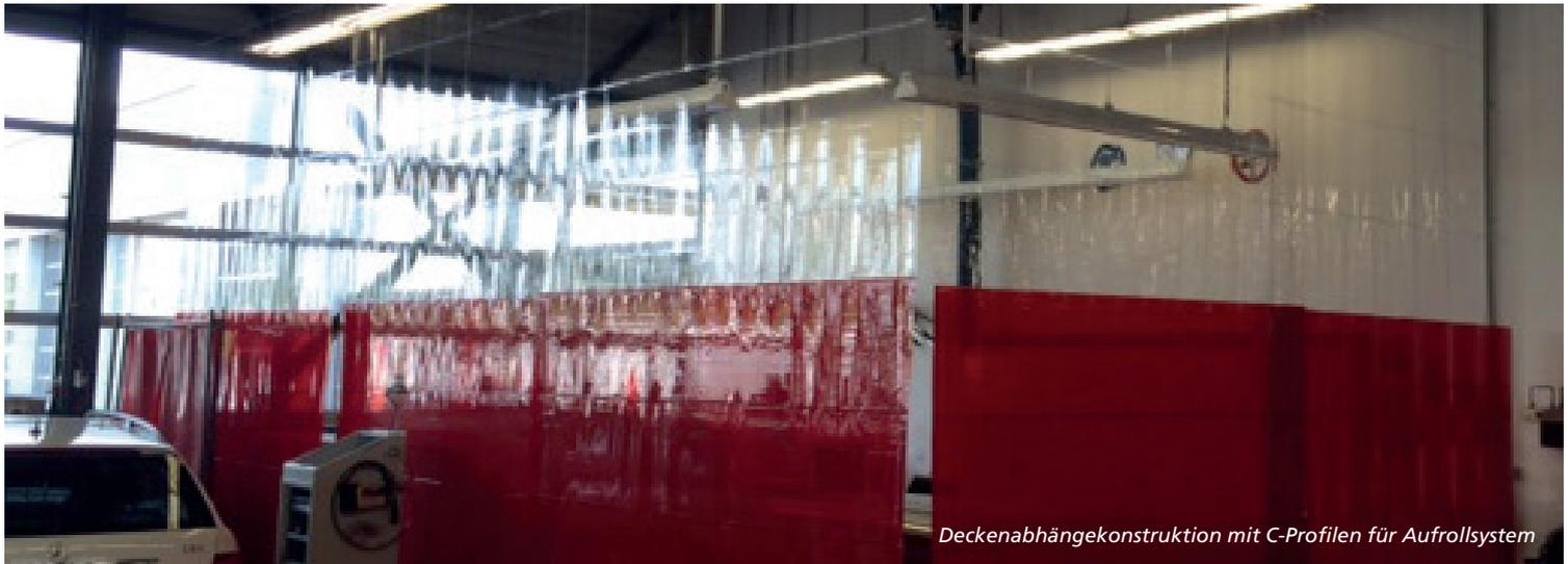
Deckenabhängekonstruktion mit C-Profilen für Aufrollsystem
