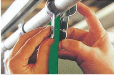
Schnelle und einfache Montage der Lamellenvorhänge. Die Lamellen werden vorgelocht geliefert. Schwingschellen vermeiden Biegeverschleiß der Lamellen
