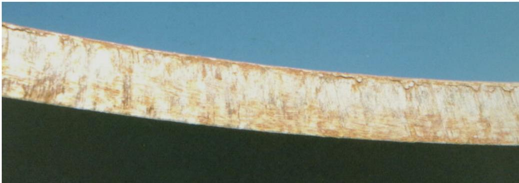
Abbildung 12. Beispiel einer Schnittkante eines reduzierten Trägerprofils
